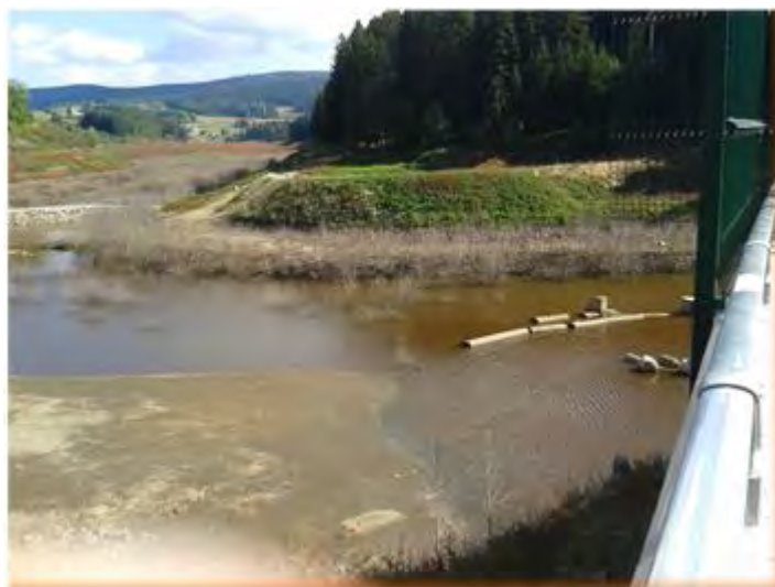
Le barrage (vide) fin septembre 2017
