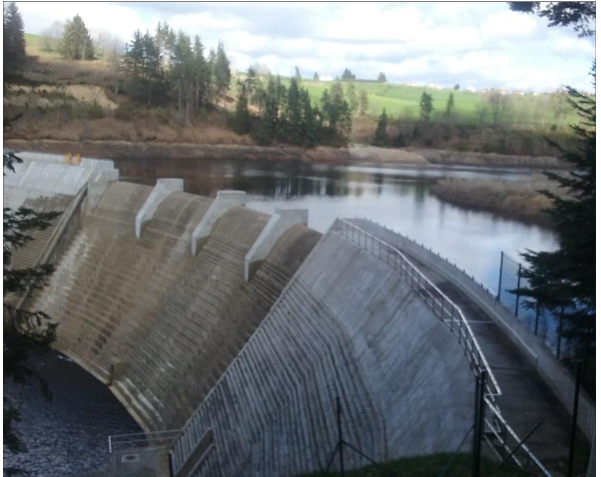
■ La retenue s'abaisse au niveau de l'ouvrage. Photo Emmanuel SAHUC
